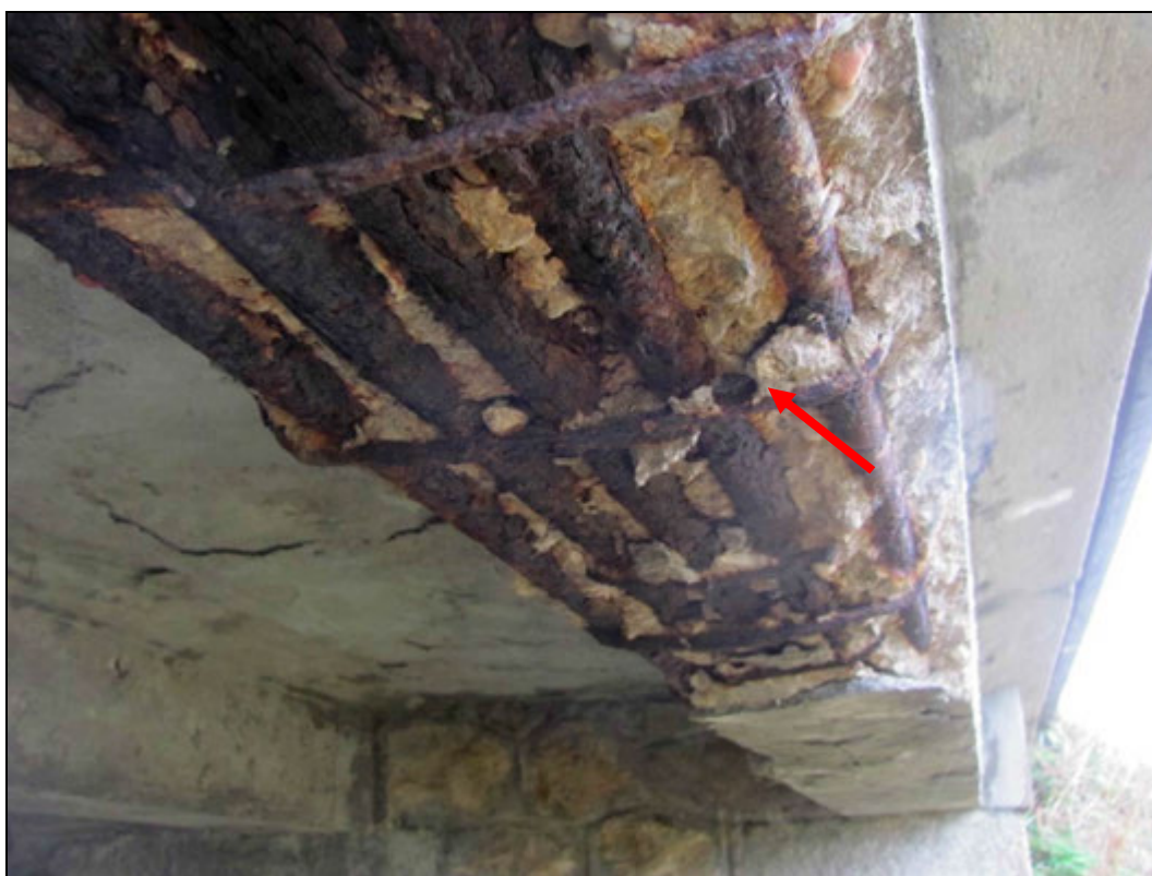
Foto 2: Silná až hloubková koroze výztuže krajních trámů, lokálně celkový rozpad třmínků.
