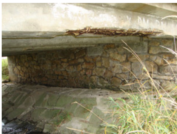
Obr. 16: Obnažená výztuž krajního trámu č.1
