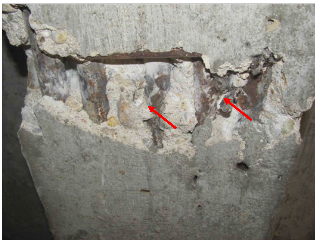
Foto 4: Provedení sondy k ověření vyztužení a stavu výztuže, spodní líc trámu. Lokální povrchová koroze.
