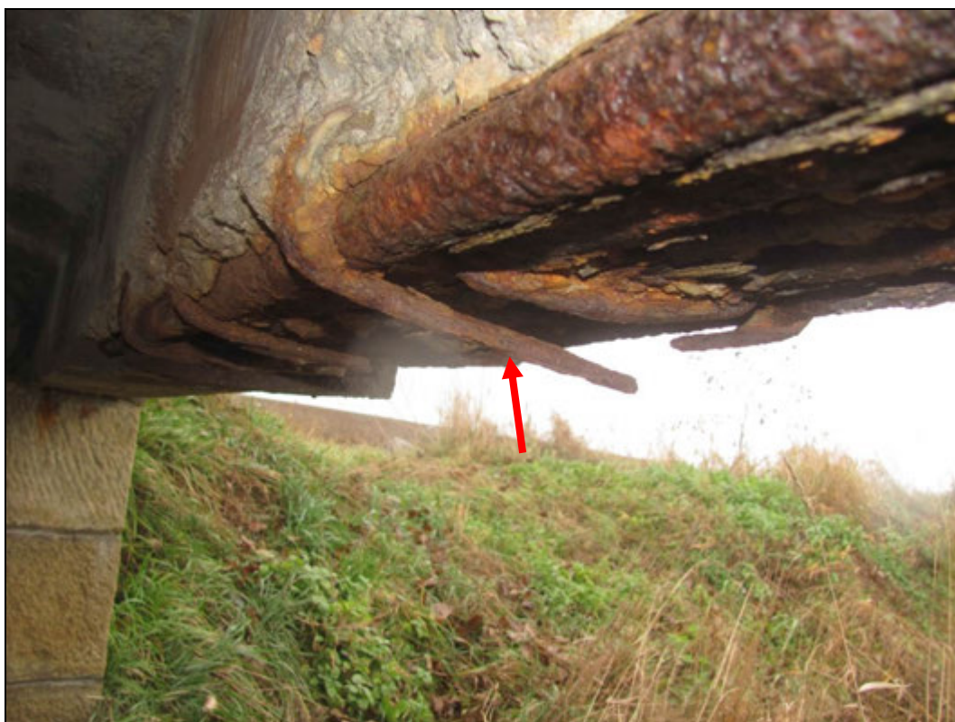
Foto 6: Rozpad třmínek trámů.
