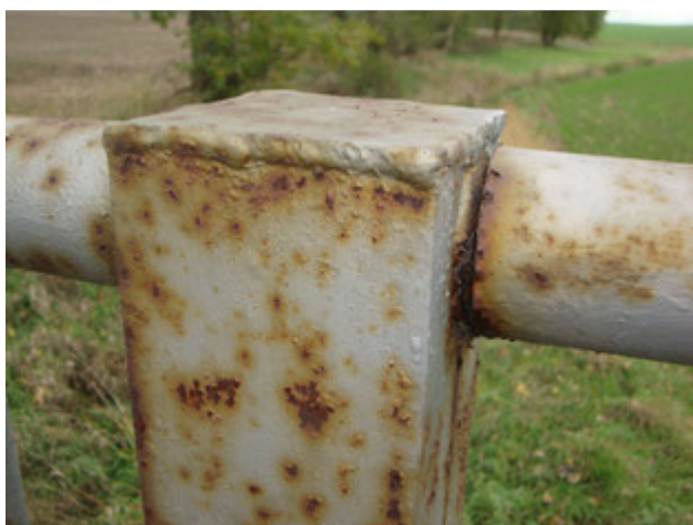
Obr. 21: Detail koroze zábradlí
