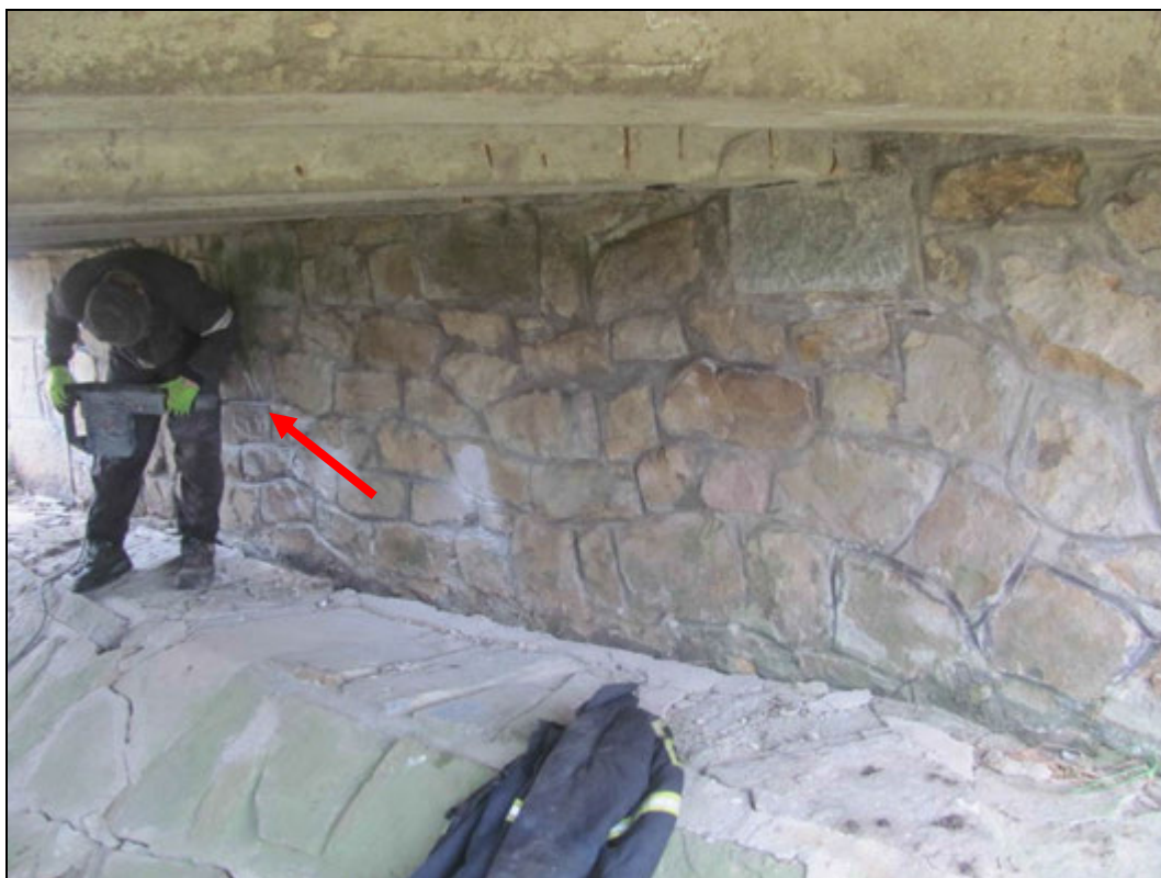
Foto 3: Provádění sondy k ověření hloubky degradace spárování.
