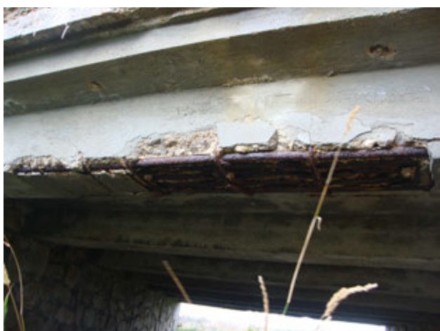
Obr. 15: Obnažená výztuž krajního trámu č.7 - detail
