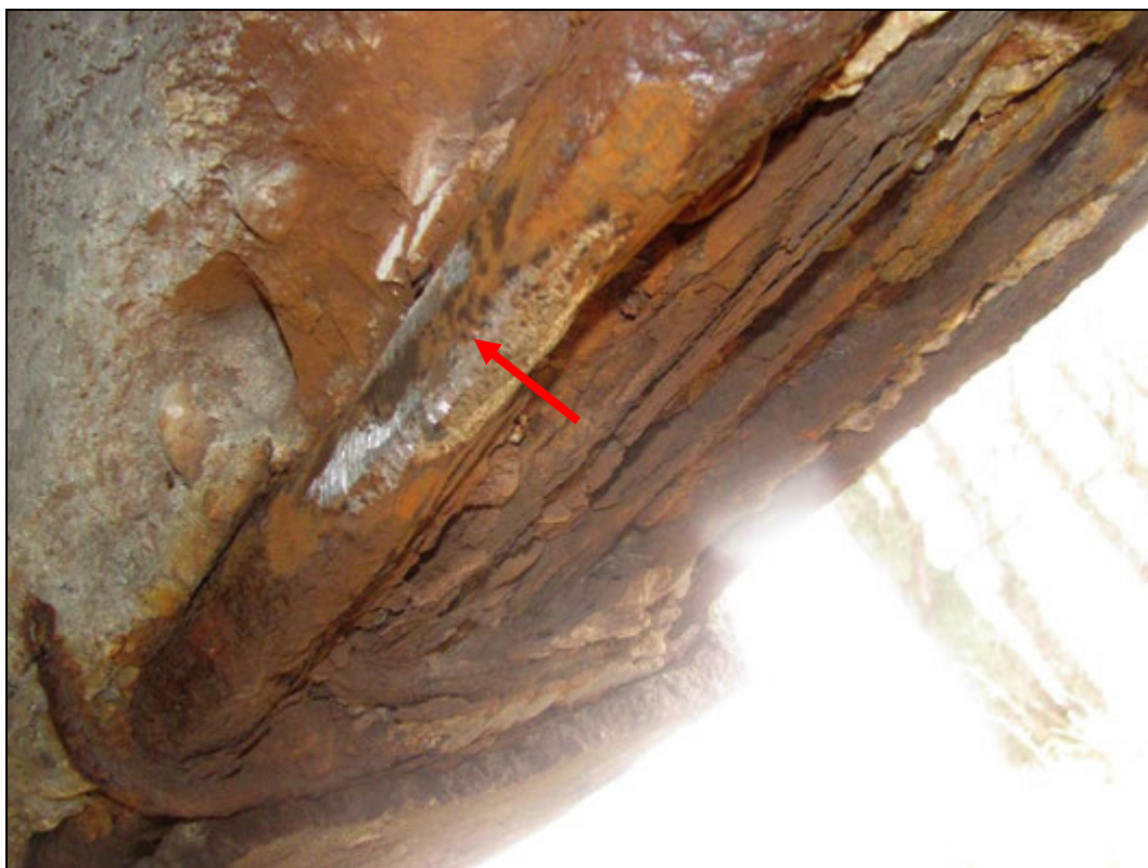
Foto 5: Provedení sondy k ověření vyztužení a stavu výztuže, spodní líc trámu. Hlubková koroze betonářské výztuže.
