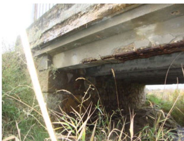
Obr. 14: Obnažená výztuž krajního trámu č.7
