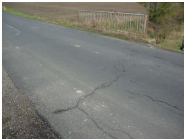
Obr. 20: Příčná trhлина v krytu vozovky u OI
