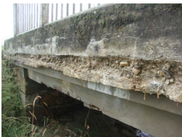
Obr. 13: Degradovaná pravá římsa na výtoku.
