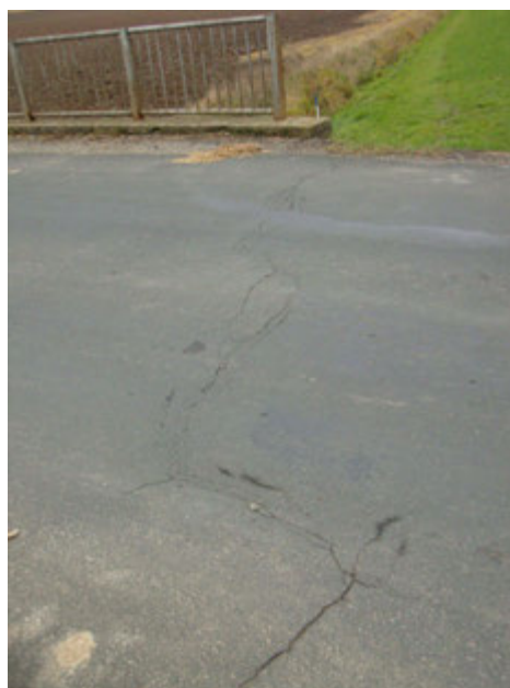
Obr. 29: Příčná trhлина v krytu vozovky u O2
