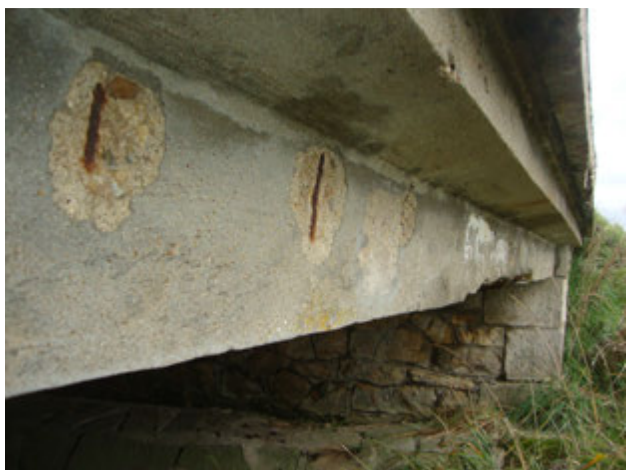
Obr. 17: Obnažená výztuž krajního trámu č.1
