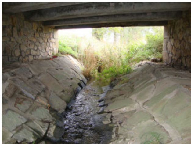
Obr. 19: Lokální poruchy v odláždění koryta pod mostem
