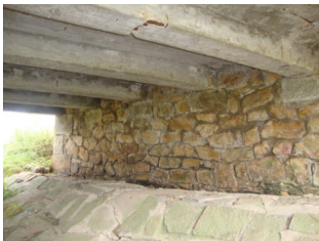
Obr. 18: Obnažená výztuž v trámu č. 5 po diagnostickém průzkumu
