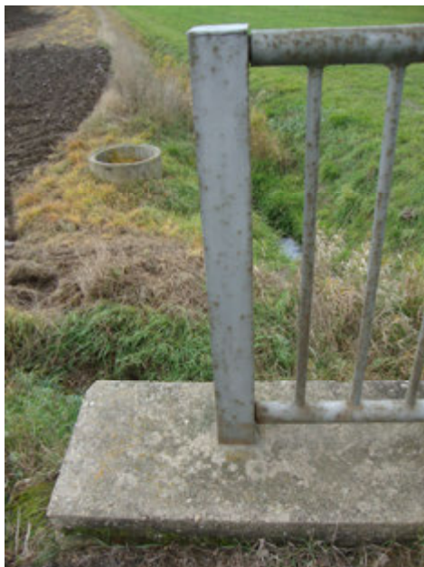
Obr. 26: Pravá římsa – koncový sloupek zábradlí (O1)
