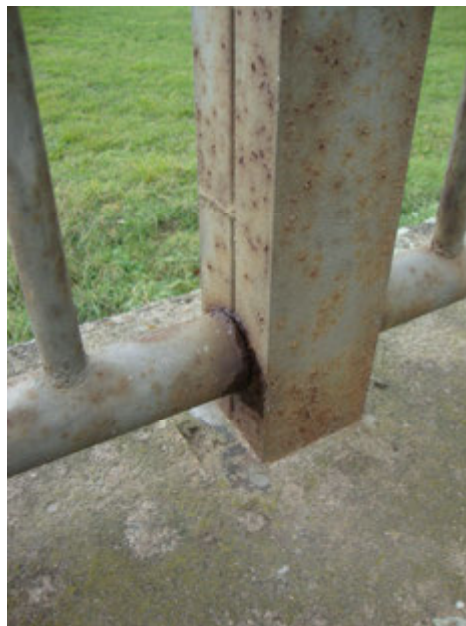
Obr. 27: Zábradlí – detail připojení dolního madla
